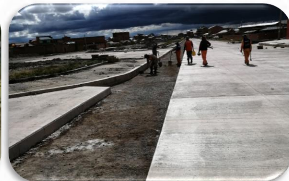
CONST. PAVIMENTO RIGIDO AVENIDA INTEGRACION DISTRITAL
