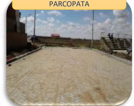
ENLOSETADO AVENIDA S/N PARCOPATA
