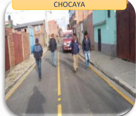
ASFALTO FLEXIBLE CALLE CHOCAYA
