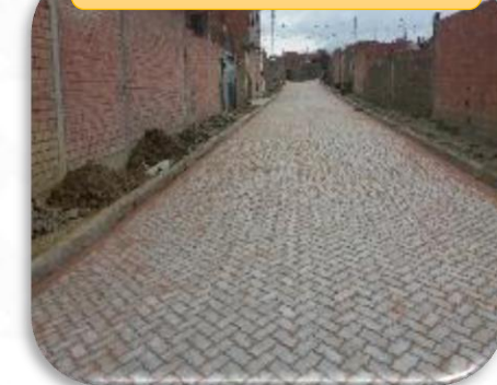
CONST. ENLOSETADO CALLE CAMACHO
