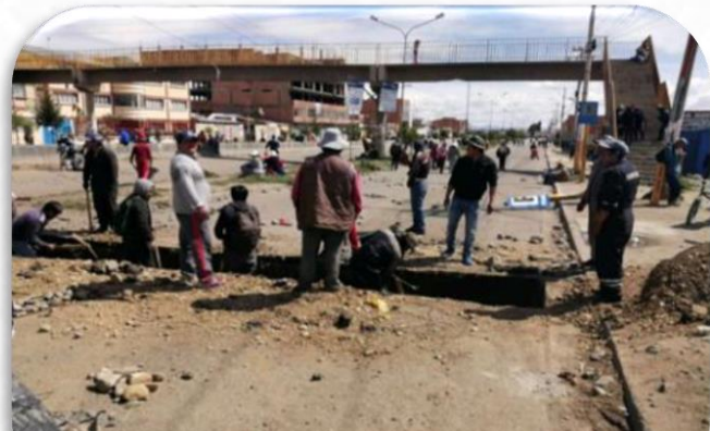
AV. 6 DE MARZO SENKATA APERTURAS DE ZANJAS
