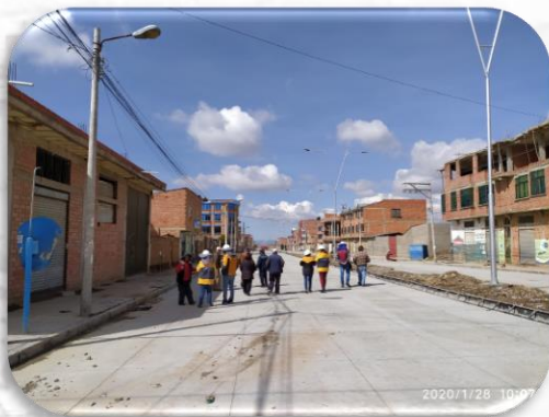
CONST. PAVIMENTO RIGIDO AV. NESTOR GALINDO (DESDE AV. ESTRUCTURANTE HASTA AV. JACHA TUPU) DISTRITAL
