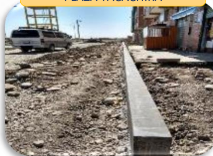
CORDONES DE ACERA PLAZA TACACHIRA
