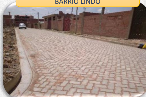
CONST. ENLOSETADO CALLES F Y 1 BARRIO LINDO
