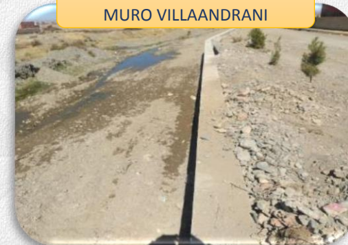
MURO DE CONTENCIÓN MURO VILLAANDRANI
