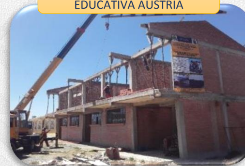
CONSTRUCCION UNIDAD EDUCATIVA AUSTRIA
