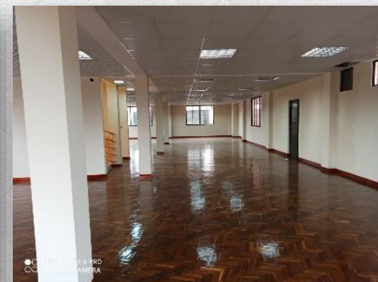
CONST. SEDE SOCIAL (FASE III) ALTO LIMA 3RA SECC. SUD. DISTRITO - 6
