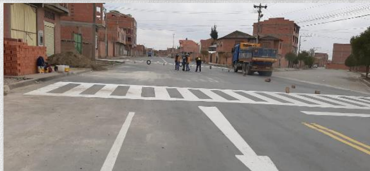
CONST. PAVIMENTO FLEXIBLE AV. 6 DE JUNIO COSMOS 79 UV "G" DISTRITAL D-3
