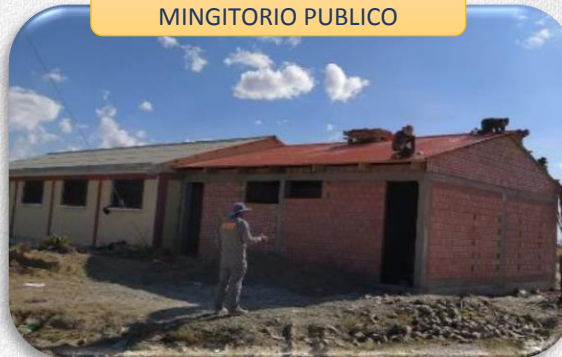
CONSTRUCCION DE MINGITORIO PUBLICO
