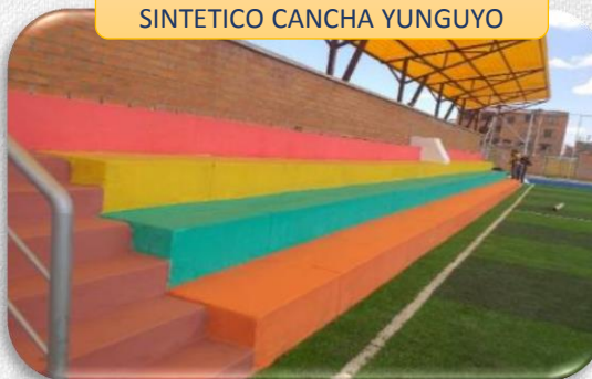
COLOCACION DE CESPED SINTETICO CANCHA YUNGUYO
