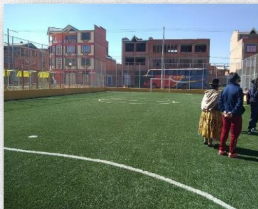
CONST. CANCHA DE CESPED SINTÉTICO VILLA TUNARI 4TA. SECCION DISTRITO - 4
