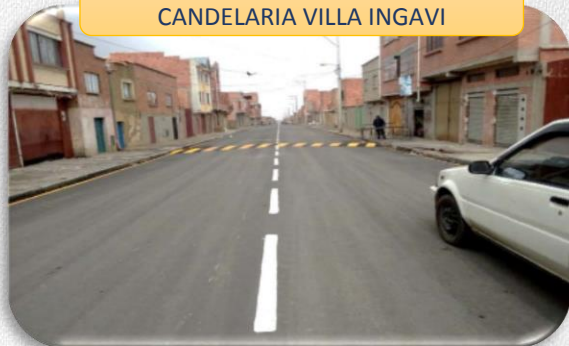
CONST. ASFALTO FLEXIBLE AV. CANDELARIA VILLA INGAVI
