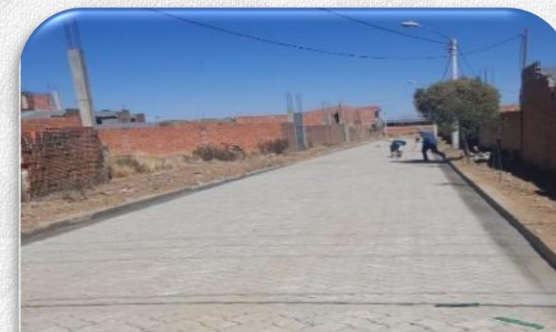
CONST. ENLOSETADO CALLE MANUEL CABALLERO FRANZ TAMAYO SECTOR D DISTRITO - 14
