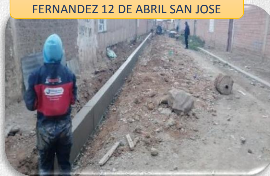
CONST. CORDON DE ACERA AV. FERNANDEZ 12 DE ABRIL SAN JOSE
