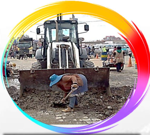
CARGUIO DE ESCOMBROS Y TIERRAS A LA VOLQUETA APERTURA DE ZANJAS,POZOS SEPTICOS Y OTROS TRABAJOS
