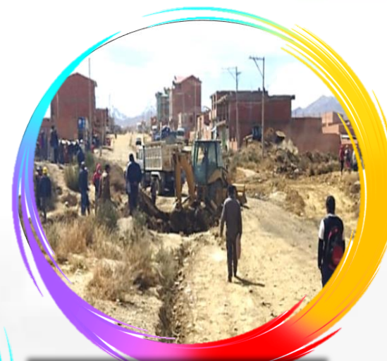
MEJORAMIENTO DE AVENIDAS TRONCALES CON MAQUINARIA PESADA
