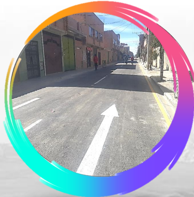
CONST. ASFALTO FLEXIBLE CALLE LAUREANO MACHACA EL INGENIO D-1 U.V.3
