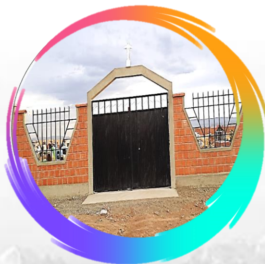
CONST. MURO PERIMETRAL CEMENTERIO POMAMAYA ALTA
