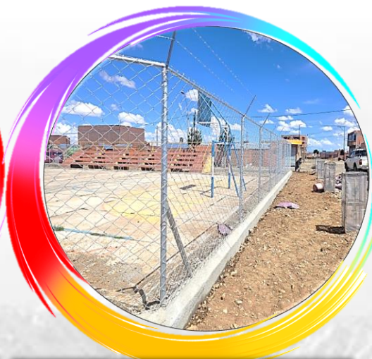
CONST. ENMALLADO DE CANCHA 2 DE AGOSTO
