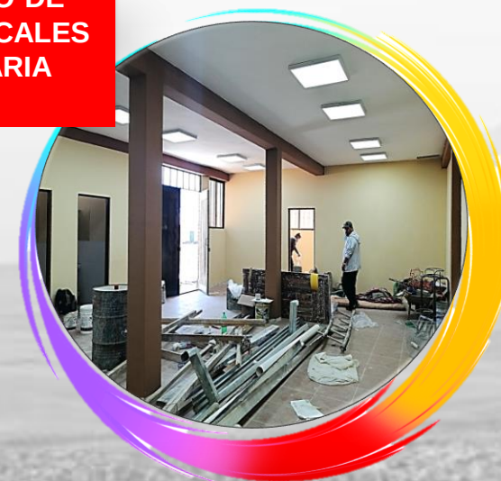
MEJORAMIENTO DE AVENIDAS TRONCALES CON MAQUINARIA PESADA
