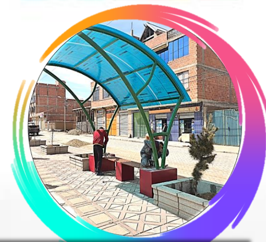
CONST. JARDINERAS CENTRAL EN AV. 12 DE DICIEMBRE GENERAL PANDO DISTRITO-8
