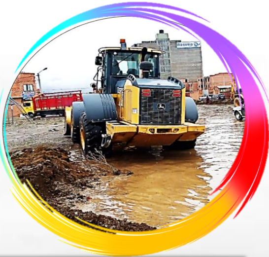
CARGUIO DE ESCOMBROS Y TIERRAS A LA VOLQUETA ,OTROS TRABAJOS
