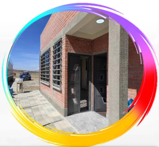
CONST. DE CAMERINOS EN CANCHA DE FUTBOL EL INGENIO
