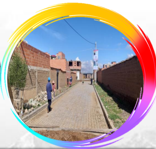
CONST. ENLOSETADO ENLOSETADO DE CALLES
