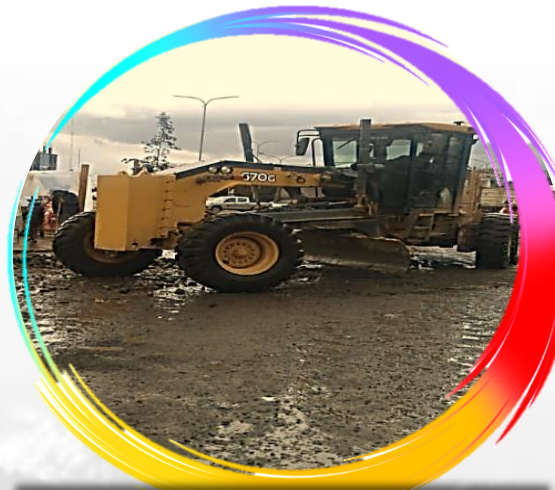
PERFILADO Y CUNETEADO DE CALLES, CANCHAS, PLAZAS, AVENIDAS EN DIFERENTES URBANIZACIONES.
