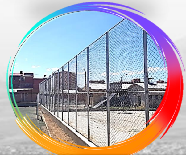
CONST. ENMALLADO EN AREA DEPORTIVA DISTRITO-8
