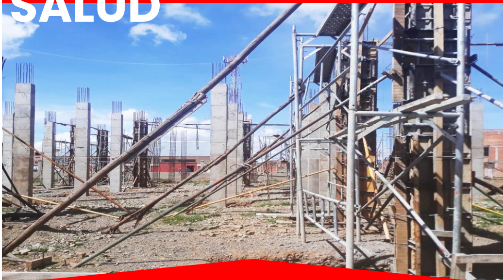
CONSTRUCCIÓN “QULLA UTA” D – 3 (Farmacia Municipal)
