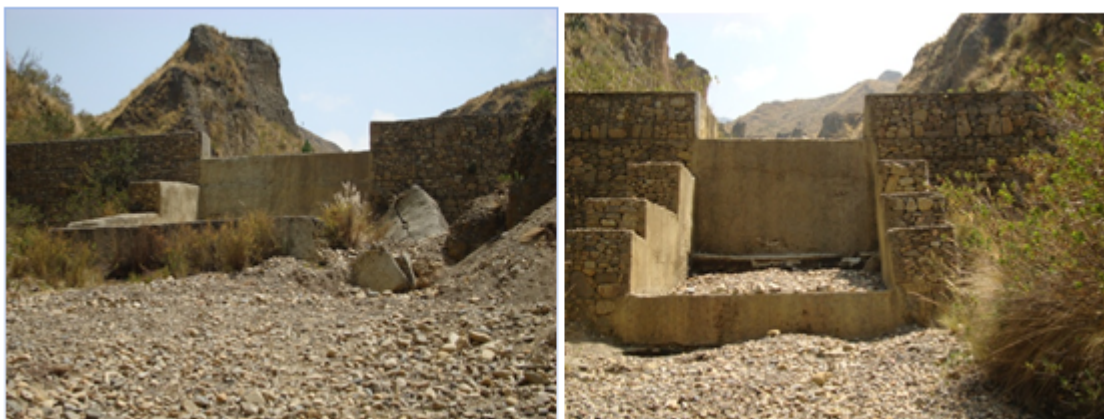
Figura 17. Obras existentes. Izq. necesita ser rehabilitada. Der. Obra en buen estado
